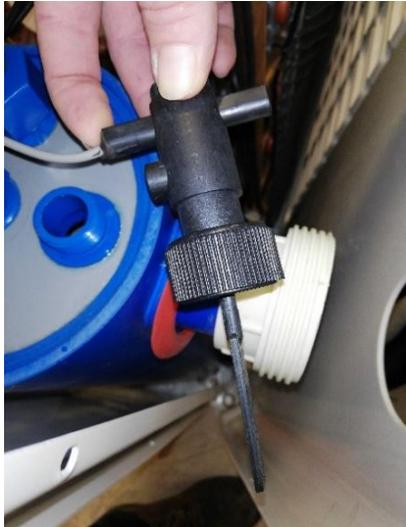
Une fois le nouveau flow switch branché, il faut le replacer sur l'échangeur titane et relancé la pompe à chaleur.
